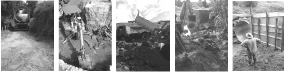
A Prefeitura de Bom Reposo continua trabalhando intensamente na zona rural do município. Neste mês, além das manutenções das estradas rurais, começou os trabalhos da ponte do Bairro dos Rodrigues. O Tubo Ármico foi conseguido junto a Secretaria Estadual de Obras (Setop) e a ponte será feita com recursos próprios.
