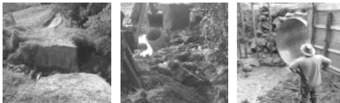
Ponte do Bairro Rodrigues em Bom Repouso
