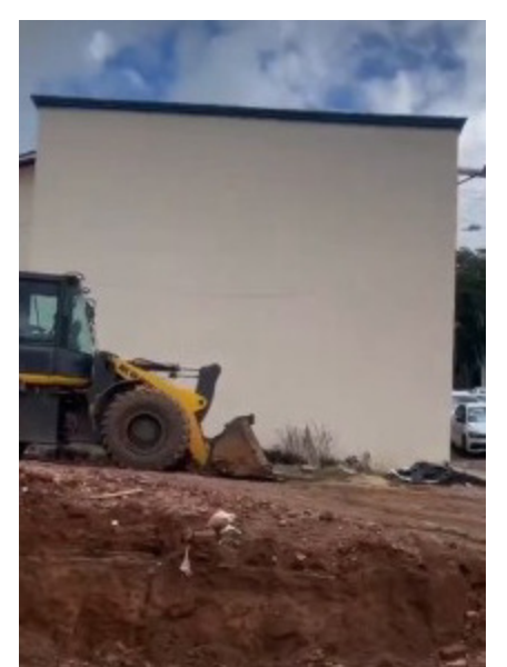
Terreno onde a UBS será ampliada
