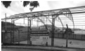
Cobertura da Quadra da Escola do Nossa Senhora de Fátima
